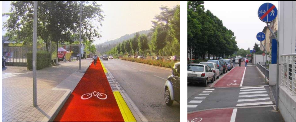
Fig. 4.10 - Pista corsia riservata su strada a sx, contigua al marciapiede dx
